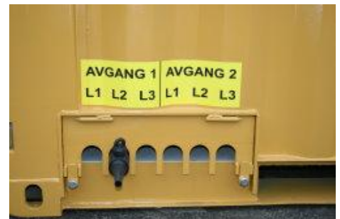
Utvendig tilkobling 11kV
